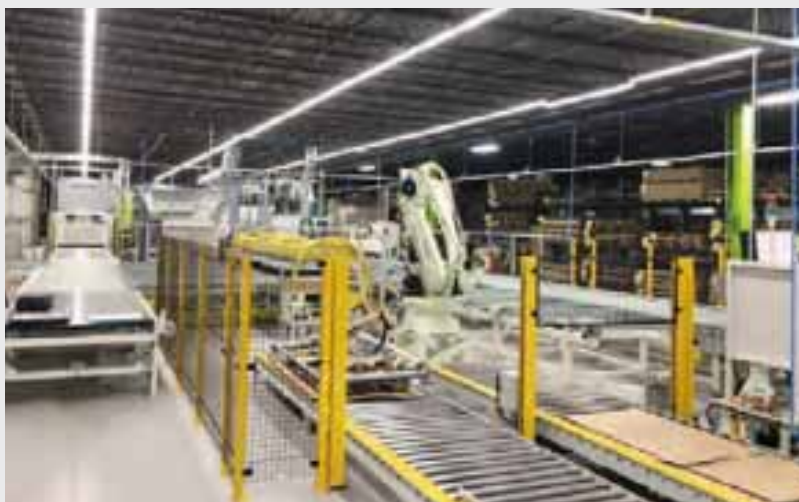
Superfici installation at Masonite in the USA.
