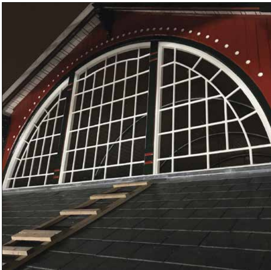
Restaureringsarbejder og genskabelse af klassisk arkitektur som her på Østerport er en af kompetencerne i virksomheden.
